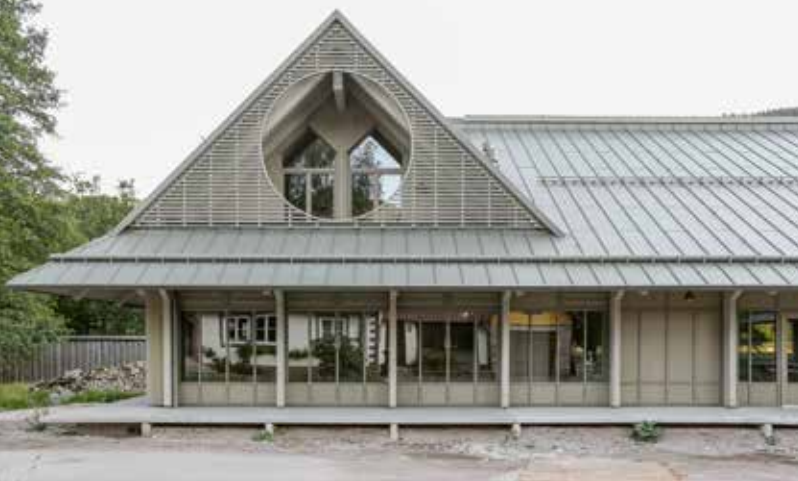
Ecole de Osterhof, par Thomas Krüger Architekten.
