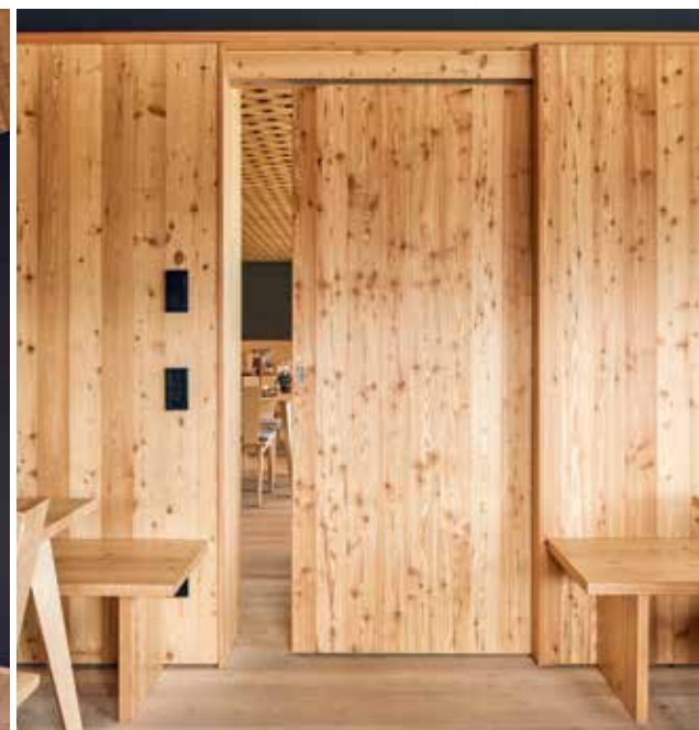
La porte coulissante s'intègre à la surface du mur.
