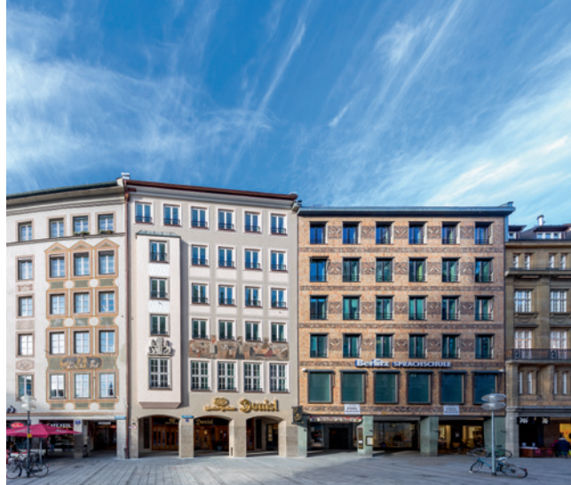
Die Fassade aus den 1950er-Jahren blieb bestehen.
