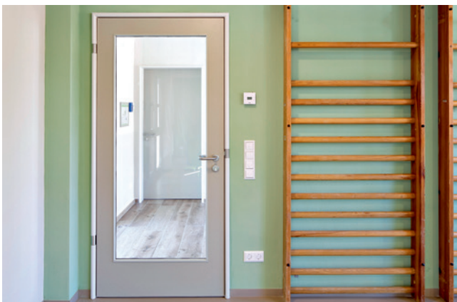
Brand- und Schallschutztür mit Stahlrundformzarge „Kita-Ausführung“.
