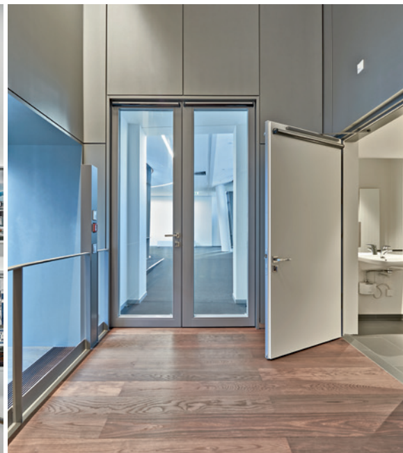
Holz-Brandschutztür mit Glasausschnitt sowie WC-Tür.
