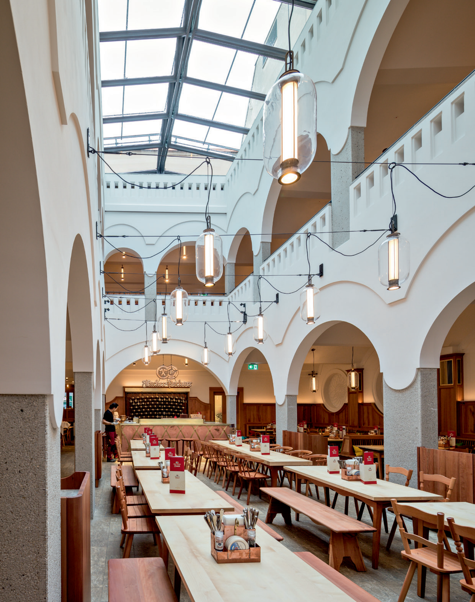
Die Bögen im Erd- und Obergeschoss haben unterschiedliche Radien.
