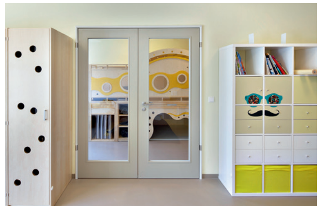
Schallschutztür 2-flügelig mit Lichtausschnitt und Stahlrundformzarge.
