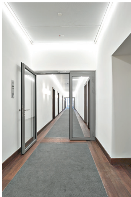
Brandschutz-Rohrrahmentür mit festem Glasflügel, teilweise mit unterschiedlicher Farbe beschichtet.
