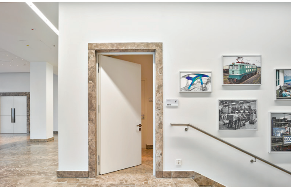
Die Fußbodenleiste wird als Rahmen um die Schörghuber Schallschutztür fortgeführt.
