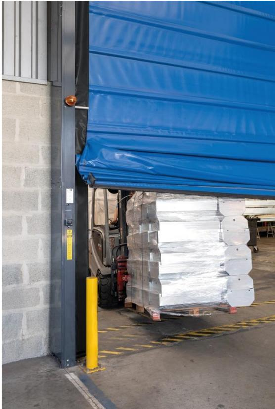
**Bild 2:** Die patentierten, flexiblen Führungsurte aus PVC schützen vor Beschädigungen. Nach einem Unfall wird die Bodenschiene des Behanges aus den Führungsurten gedrückt. Anschließend kann der Behang ohne fremde Hilfe wieder eingefädelt und das Tor weiterbetrieben werden.
