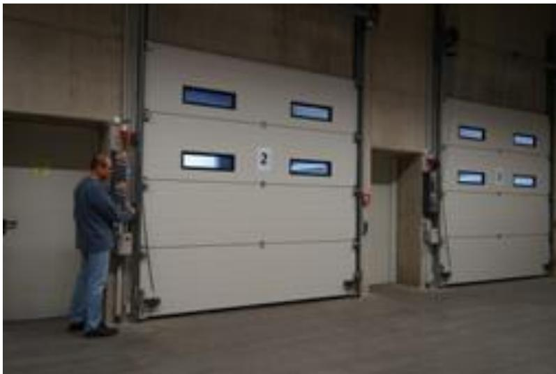
**Bild 5:** Die vorgelagerten Verladestationen des Gauselmann Logistikzentrums sind mit Industrie-Sectionaltoren SPU F42 abgeschlossen. Eine Sandwich Verglasung sorgt für den sicheren Blickkontakt zur Verladestation.
