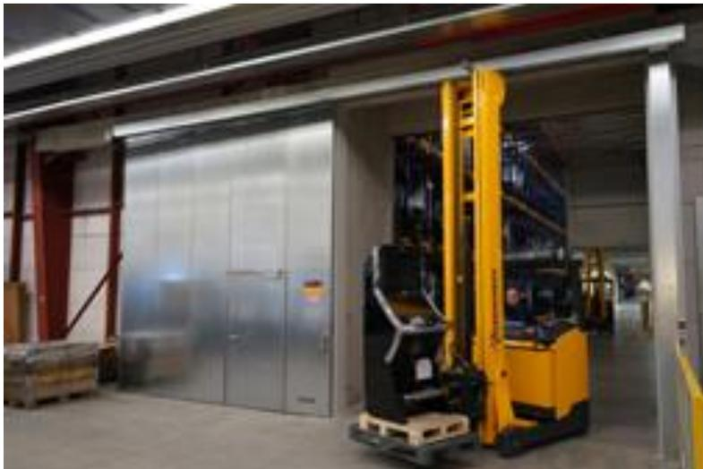
**Bild 3:** Zwischen den Hallenübergängen sorgen speziell für dieses Projekt produzierte Feuerschutz-Schiebetore von Hörmann für den Brandschutz. Damit die Flurförderzeuge mit Triplex -Mast passieren können, mussten die Tore eine Höhe von 4,50 Meter haben.
