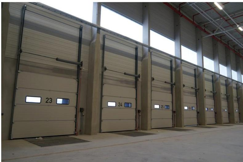
**Bild 4:** Einige der eingesetzten Hörmann Industrie-Sectionaltore in dem Norma Logistikzentrum sind mit einem speziellen Beschlag ausgestattet, sodass die Tore vertikal an der Hallenwand entlang öffnen. Dies bietet sich besonders bei hohen Räumen an, wie es in Produktions- oder Logistikhallen der Fall ist.
