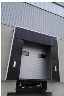
**Bild 2:** Bei der Verladetechnik entschied sich Goldbeck für den Einsatz eines Hörmann Komplettsystems bestehend aus Verladebrücken, Torabdichtungen und gedämmten Industrie-Sectionaltoren.
