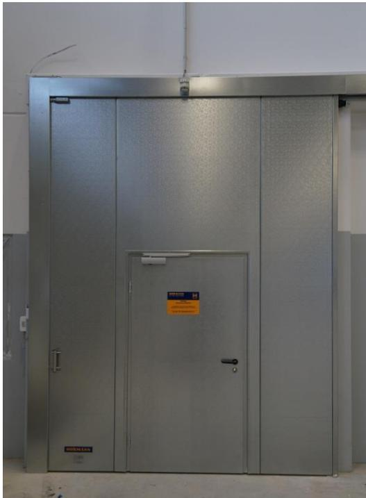
**Bild 6:** Für den erleichterten Personendurchgang sind einige der in dem Norma Logistikzentrum in Aichach eingesetzten Hörmann Feuerschutz-Schiebetore mit Schlupftüren ausgestattet. So wird sowohl ein für jeden Personendurchgang vollständiges Öffnen des Schiebetores als auch die Planung einer zusätzlichen Brandschutztür neben dem Tor vermieden.
