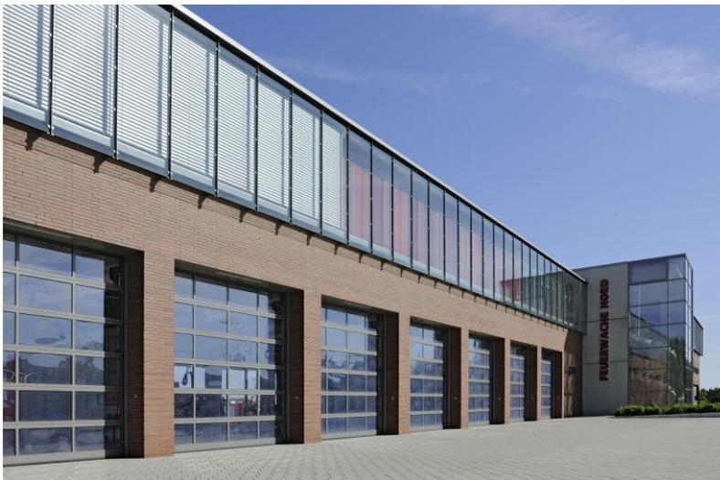
**Bild 2:** Die bodenflächig verglasten Aluminium-Sectionaltore von Hörmann sorgen für viel Tageslichteinfall und höchste Transparenz und fügen sich harmonisch in die Fassade des Gebäudes ein.
