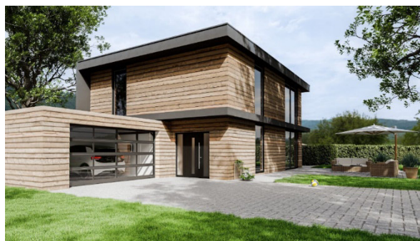
Das moderne ART 42 Thermo lässt durch die Verglasung viel Licht in die Garage.
