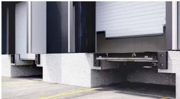
Outre les portes isolées et rapides, les équipements de quai à faible consommation d'énergie revêtent également une grande importance, comme le niveleur de quai à lèvre télescopique hydraulique HTL2 ISO qui, avec ses panneaux isolants de 50 mm d'épaisseur, assure une isolation thermique jusqu'à env. 55 % supérieure à celle des niveleurs de quai traditionnels.
