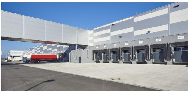
Porte sectionnelle SPU F42 en combinaison avec des niveleurs de quai isolés et des sas d'étanchéité – Les portes sectionnelles et les motorisations sont parfaitement adaptées aux équipements de quai Hörmann.
