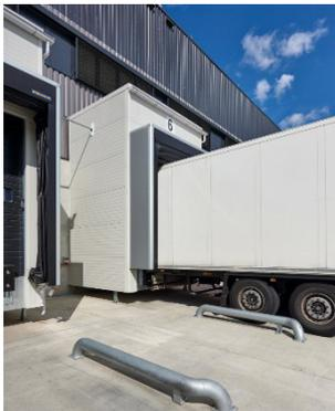
Befindet sich die Vorsatzschleuse direkt innerhalb einer Kühlzone, bestehen erheblich höhere Anforderungen an die Wärmedämmung. Hörmann Thermoschleusen sind im Dach-, Wand- und Bodenbereich mit einer 80 mm dicken Sandwichbeplankung ausgestattet.
