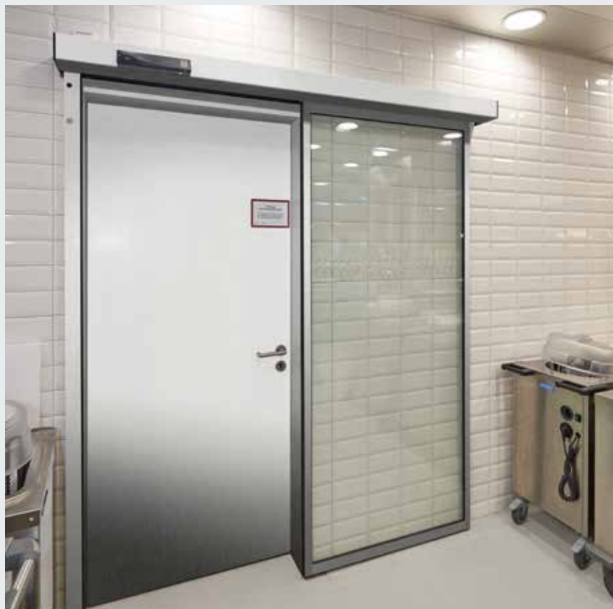
Funcionamiento nocturno con puerta cortafuego cerrada
