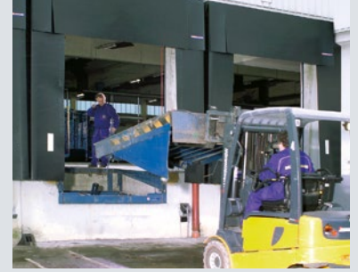
Eski rampa sökülür, gerekli olması halinde çukur montaj plakaları veya destek konsolları ile montaj ölçülerine uyarlanır
