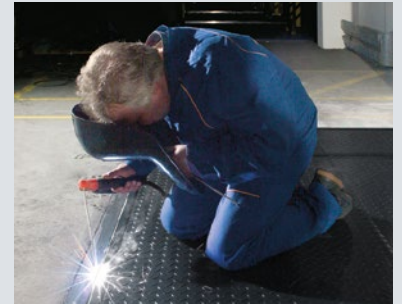
Kenar köşebentlerine kaynak yapılır – montaj tamamlandı.
