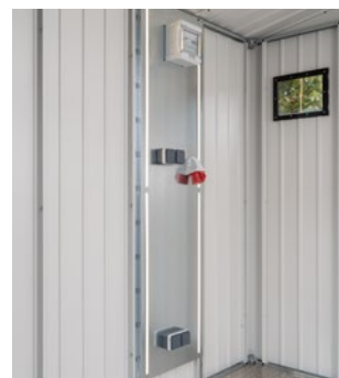
Panel elektryczny z gniazdami, oświetleniem LED i opcjonalnym podłączeniem zasilania trójfazowego szer. × wys.: 47 × 180 cm
