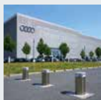
Systèmes de contrôle d'accès
