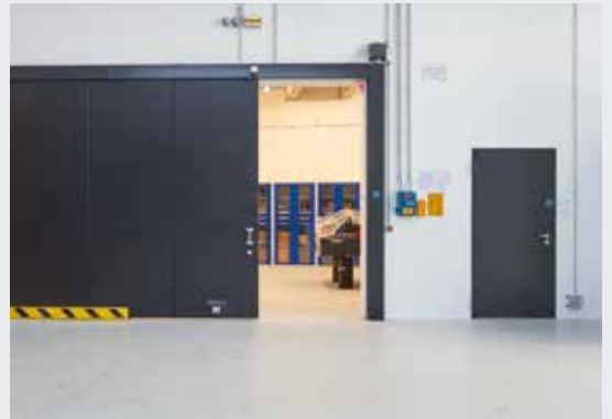
Boyalı kapı kanadı ve kasası
