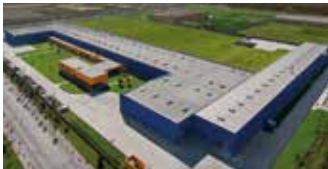
Hörmann Tianjin, Κίνα
