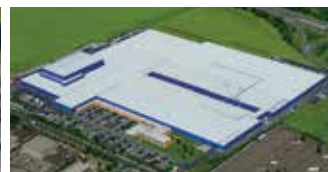
Hörmann KG Ichttershausen, Allemagne
