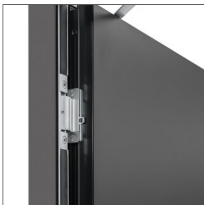
Widok ukrytego zawiasu z zewnątrz po otwarciu
