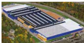
Hörmann KG Eckelhausen, Germany
