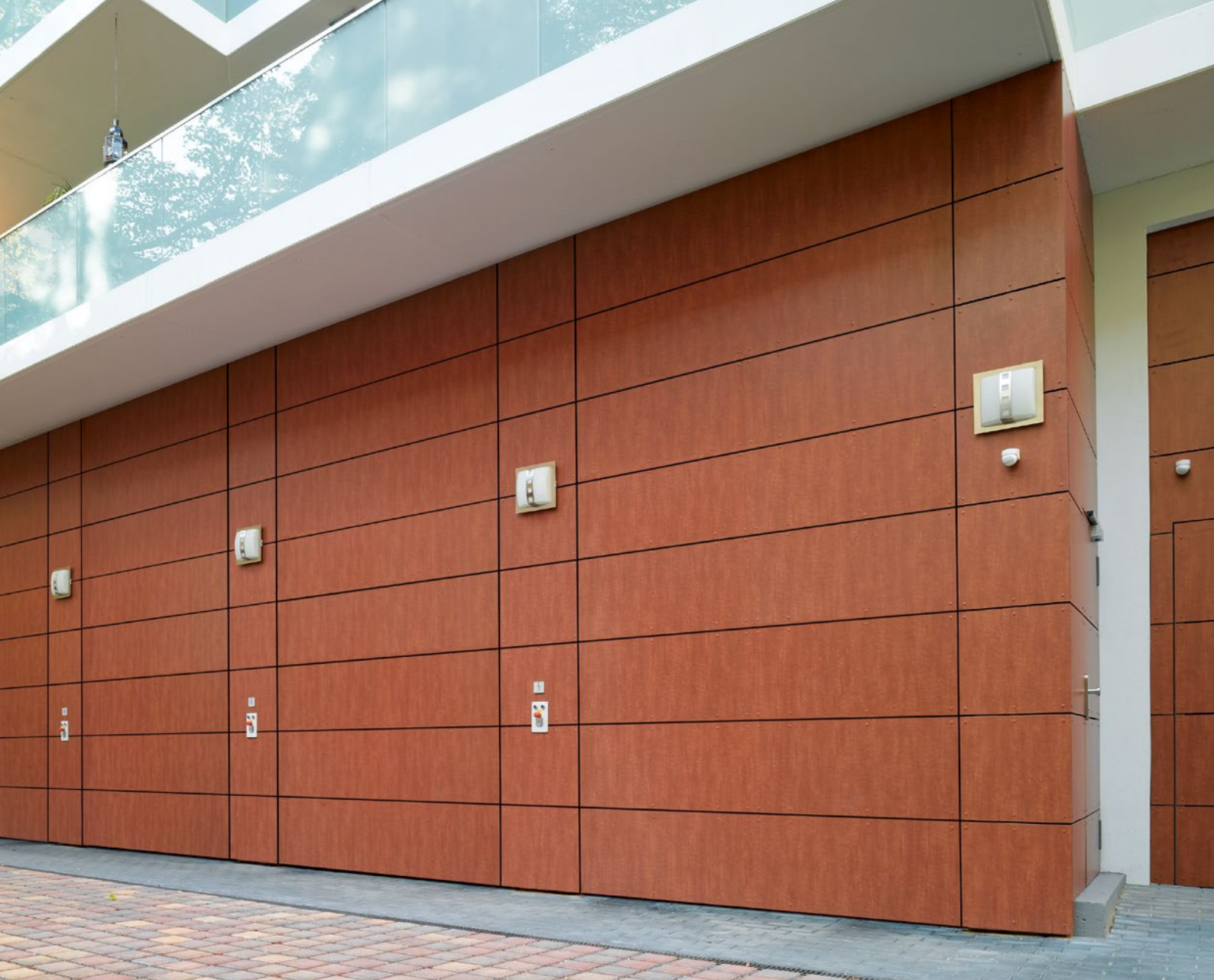
УГОРІ ПРАВОРУЧ. ALR F42 з облицюванням із ламінованих панелей, що монтуються урівень унизу. ALR F42 з облицюванням із алюмінієвих композитних панелей, що монтуються урівень
