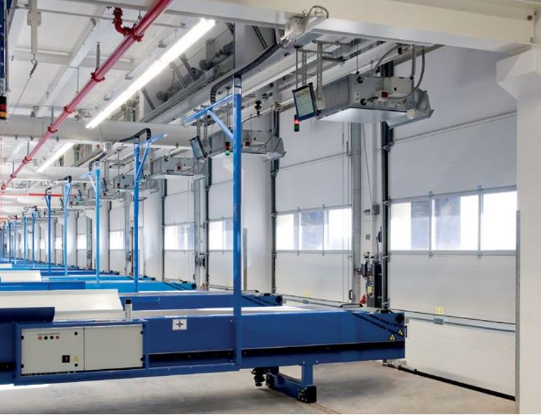
УГОРІ ЛІВОРУЧ. SPU F42 з хорошою теплоізоляцією для приміщень, що опалюються
