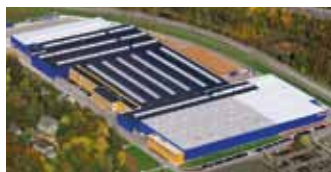
Hörmann KG Eckelhausen, Allemagne
