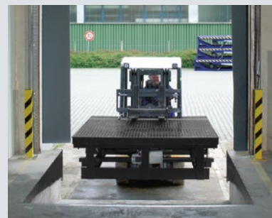
Postavljanje novog utovarnog mosta
