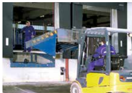
Demontere gammel lastebrygge, ev. tilpasse graven (f.eks. med monteringsplater eller konsoller)
