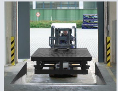
Colocar la rampa niveladora nueva
