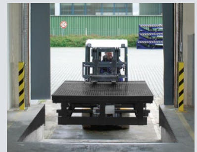
Встановлення нового перевантажувального моста
