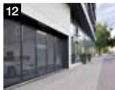
Portes de garage collectif
