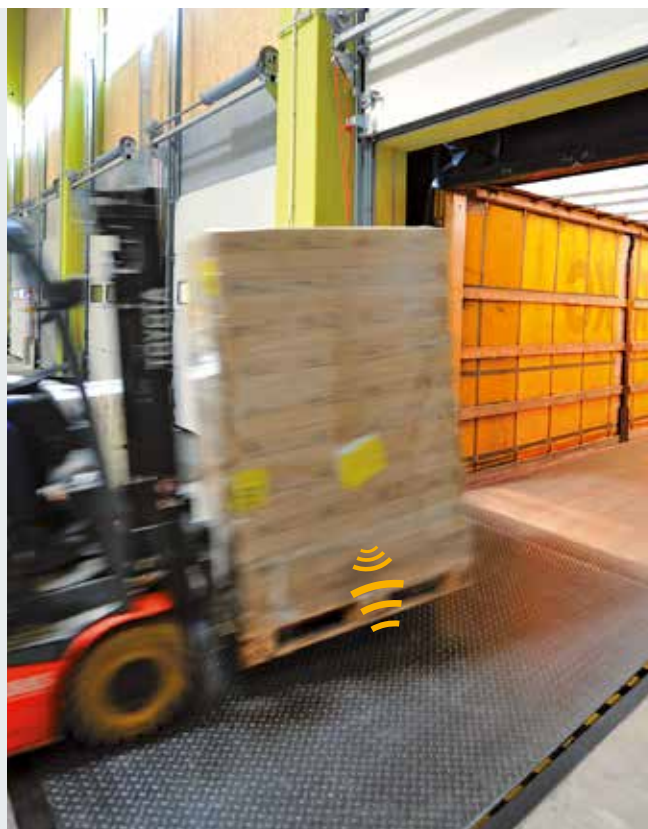
Enregistrement automatique des mouvements de marchandises lors du passage sur le niveleur de quai.
