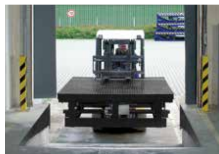
Uus laadimissild paika tõsta
