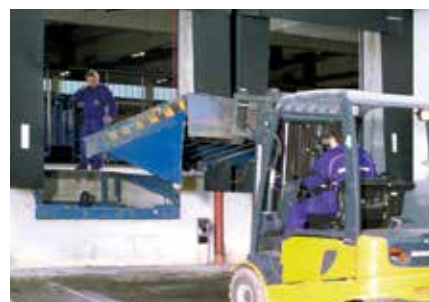
Vana laadimissilla eemaldamine, vajaduse korral süvendi kohandamine (nt kinnitusplaatide või konsoolidega)
