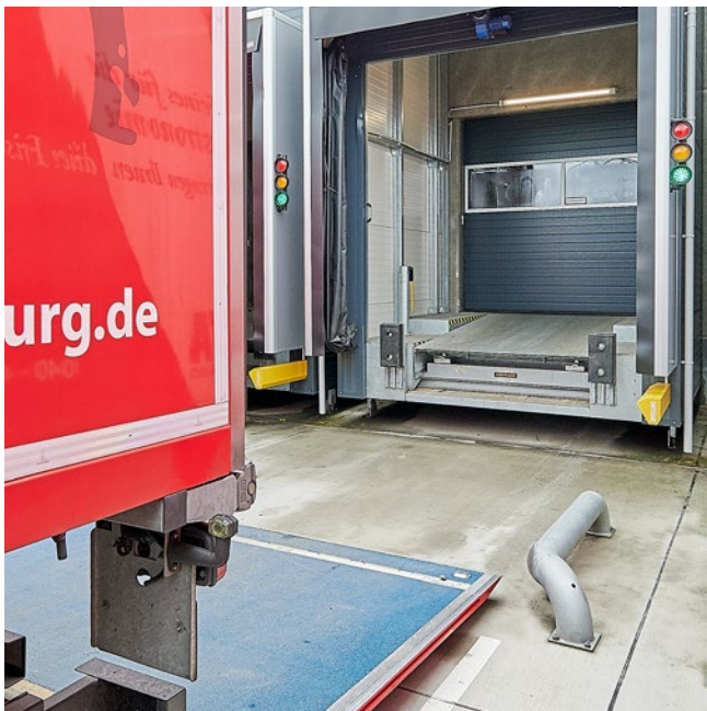
Vedení kola a podpora při přistavování DAP
