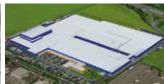
Hörmann KG Ichttershausen, Allemagne
