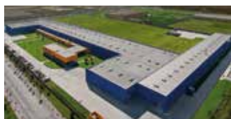
Hörmann Tianjin, Κίνα
