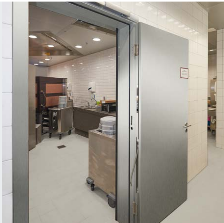
Tagbetrieb mit geöffneter Feuerschutztür
