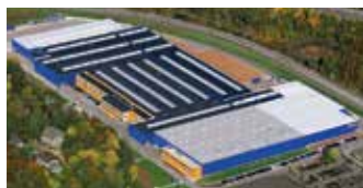
Hörmann KG Eckelhausen, Tyskland
