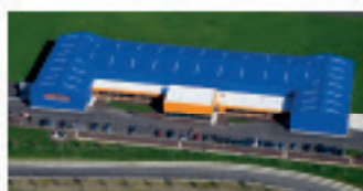
Hörmann Flexon LLC, Bungeleskown PA, USA
