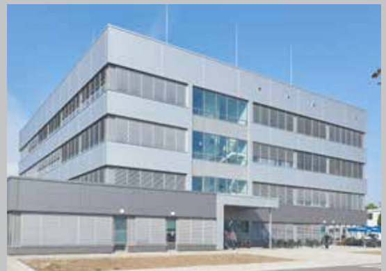
Industriële gebouwen en vakcentra
