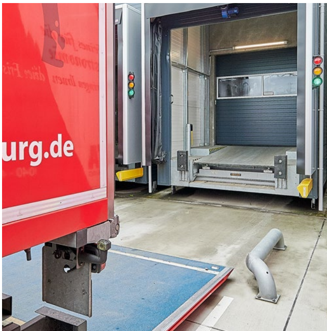
Kerékmegvezetők és a DAP dokkolássegítő rendszer
