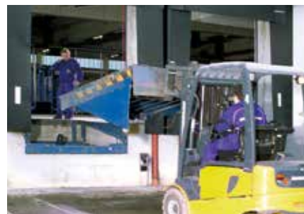
Демонтаж на старата товаро-разтоварна рампа, евентуално приспособяване на изкопа (напр. с монтажни планки или конзоли)
