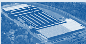
Hörmann KG Eckelhausen, Allemagne
