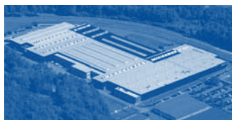
Hörmann KG Eckelhausen, Allemagne
