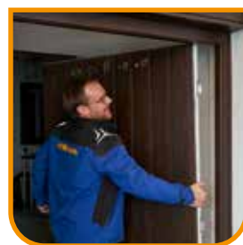
Demontaż i ekologiczna utylizacja
