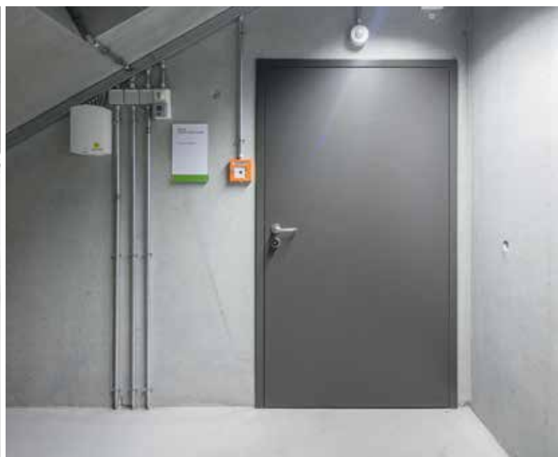
Дверное полотно закрывается заподлицо с охватывающей коробкой.
