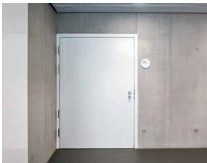
Стальная блочная коробка без строительного раствора в массивной кирпичной кладке.
