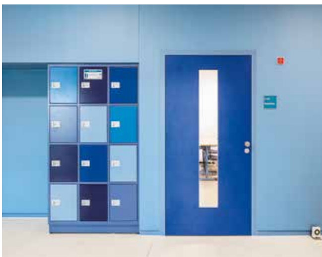
Стальная блочная коробка без строительного раствора в каркасной конструкции.
