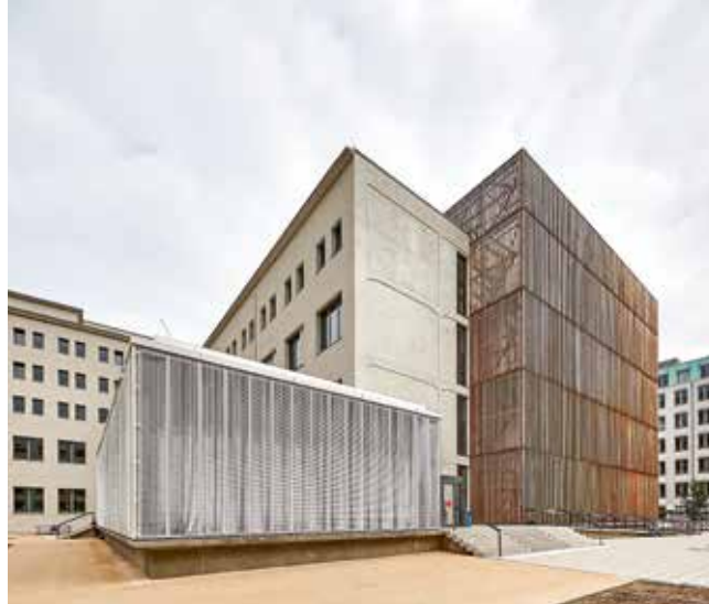
Здание со сценой и закулисными помещениями выделяется своим фасадом в виде «деревянного забора».
