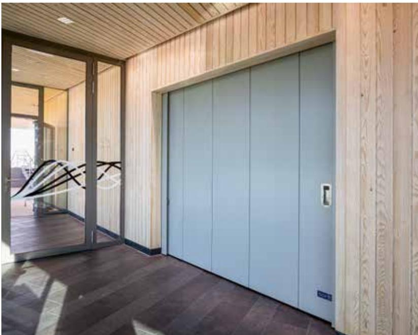
Не эвакуационный выход, а противопожарная перегородка: огнестойкие откатные ворота HORMANN, задвигающиеся в стену.
