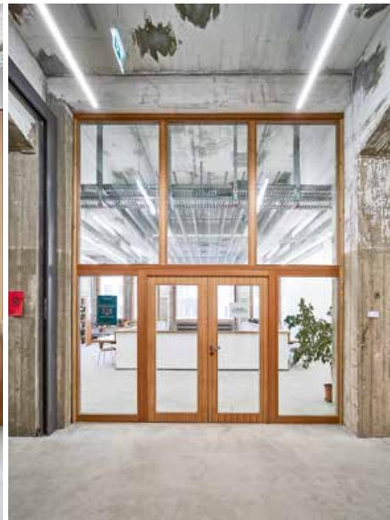
Фиксированное остекление с высокой степенью звукоизоляции.
