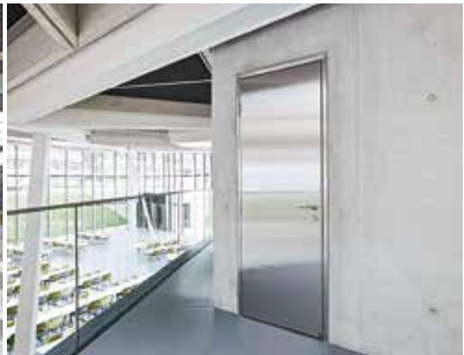
Die DryTec Blockzargen sorgen in Kombination mit einem stumpfen Türblatt für eine flächenbündige Ansicht. Sie sind auch in einer Edelstahlausführung erhältlich.
